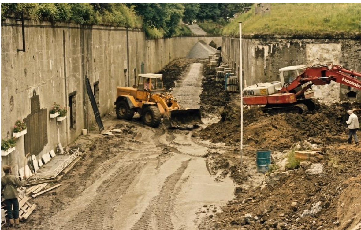
Grâce à de puissants engins de terrassement, les militaires du 4 e Bataillon de Génie ont réalisé d'indispensables travaux afin de mieux aménager le site pour l'accueil des visiteurs.
